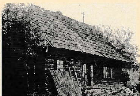
Trojpristorový dom s murovaným komínom a komorou upravenou na bývanie
